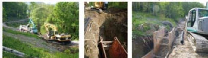
Ferrassement d'une tranchée de 1,5 mètre de largeur, 3 mètres de profondeur, 210 mètres de longueur
