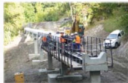
La rénovation complète de l'aménagement hydroélectrique engagée par EDF est une opération ambitieuse. Elle prévoit en particulier le remplacement du tronçon inférieur de la conduite forcée par la technique du forage dirigé. Il s'agit de percer un «tunnel» de 65 cm de diamètre au travers de la montagne sur 1000 mètres de long et avec 450 mètres de dénivelé, depuis St Martin sur la Chambre jusqu'au plateau de Montaimont.
